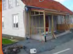
Fra ombyggingen av menighetshuset
